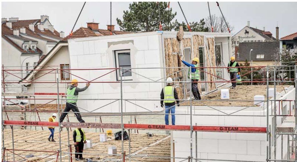
Binnen 24 Stunden wurden die Elemente beim Landzinshaus-Projekt in Wiener Neustadt vom Lkw auf die Baustelle gehoben und ein Gebäude mit 10 Wohnungen errichtet.
